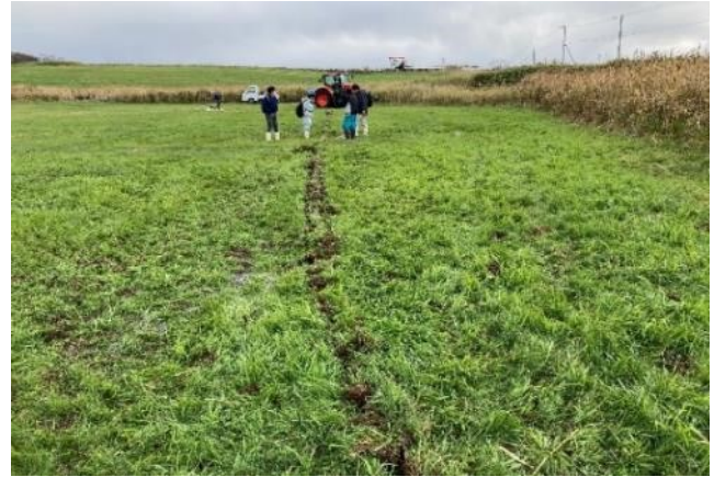
カットドレーン施工後の草地
