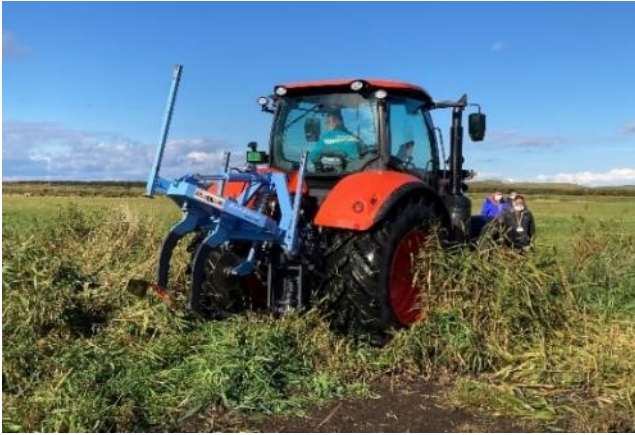
カットドレーン施工の様子
